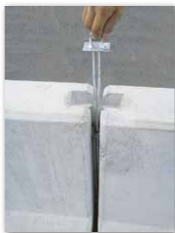
連結筋挿入状況
