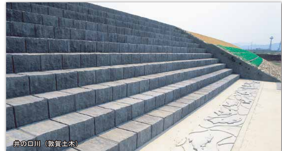
南川 (小浜土木)
