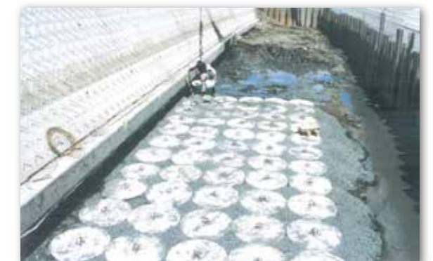
河床の浸食・洗掘防止用基礎
