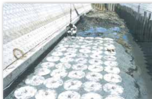
河床の浸食・洗掘防止用基礎
