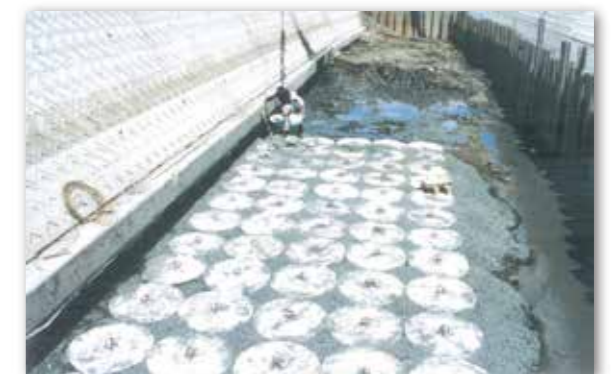
河床の浸食・洗掘防止用基礎
