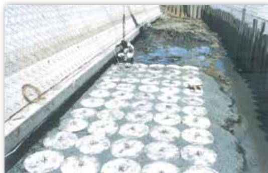
河床の浸食・洗掘防止用基礎
