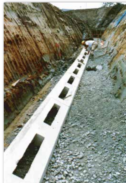
基礎ブロック布設後の様子
