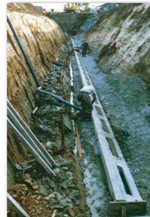
間詰コンクリート打設後の様子
