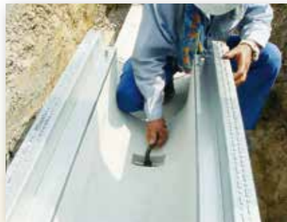
④ 固定ボルト締め
