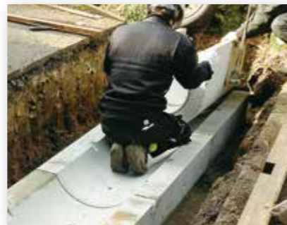
③ 側溝据え付け
