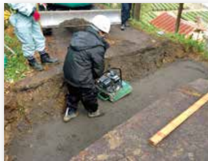
① 基礎材敷設
