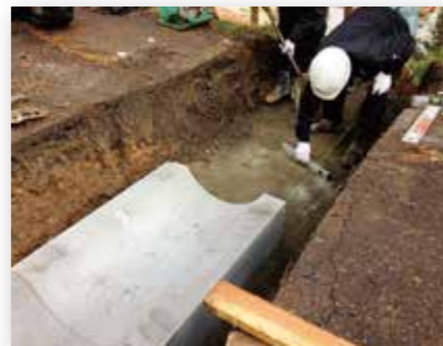
② 敷きモルタル敷設 ベースブロック据え付け
