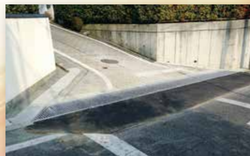
名古屋市 天白土木事務所
