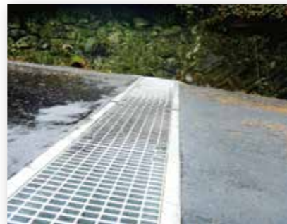
⑥ 舗装完成
