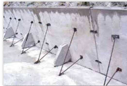
連結金具溶接完了
