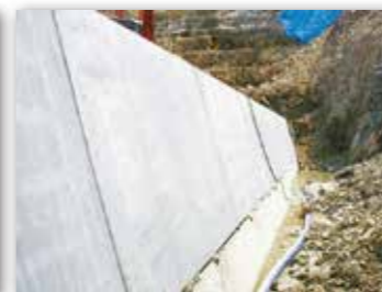
BSBブロック敷設・間詰コンクリート打設完了
