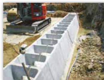
BSBブロック敷設・間詰コンクリート打設完了
