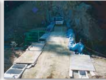
ソイルセメント積み込み・運搬・搬入
