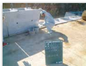
BSBブロック敷設
