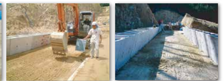
打ち継ぎ部レーキング
