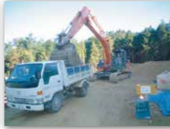
ソイルセメント積み込み・運搬・搬入
