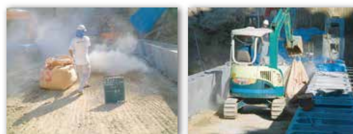
打ち継ぎ部セメント粉体散布
