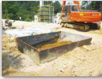
ソイルセメント攪拌混合
