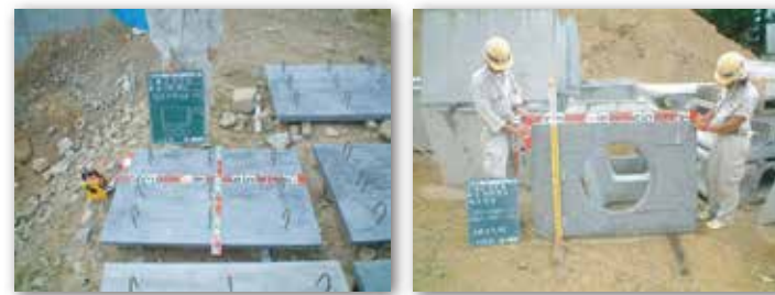
残存型枠パネル
