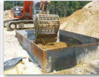
ソイルセメント積み込み・運搬・搬入
