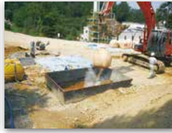
ソイルセメント積み込み・運搬・搬入
