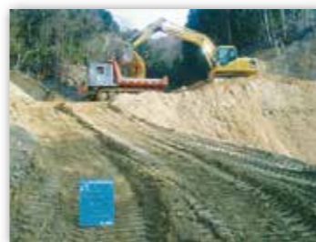
掘削土砂積み込み・集積
