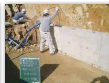
BSBブロック敷設・間詰コンクリート打設完了
