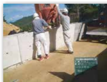
間詰コンクリート打設
