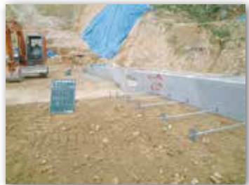
アンカー筋設置(D19 SD345)
