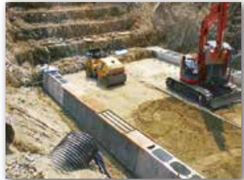
撒き出し転圧(堤体底部付近)
