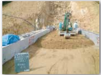
撒き出し転圧(堤体底部付近)
