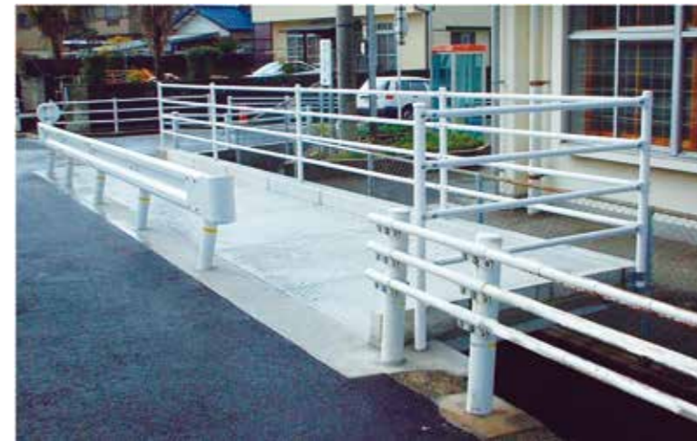
市道麻里布町3号線歩道設置工事
