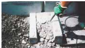
④間詰めコンクリート除去
