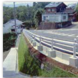
ジオテキスタイル 補強土壁
