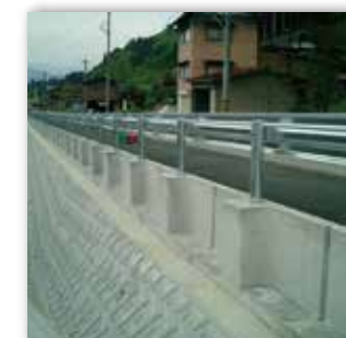
ブロック積擁壁
