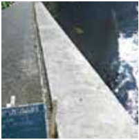
基礎コンクリート
