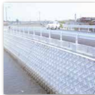
ブロック積擁壁
