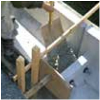
コンクリート打設状況
