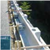
製品・型枠設置完了
