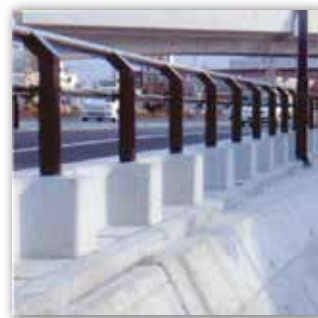
大型ブロック積擁壁
