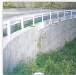
補強土壁 (アデムウォール)
