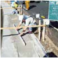
敷きモルタル
