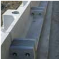
間詰めコンクリート完了
