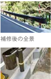
補修した2本の近景
