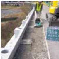
埋戻し、路盤工施工
