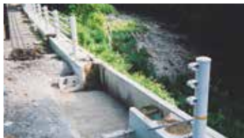
⑤製品を撤去した状況
