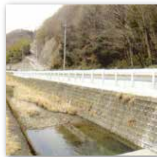
既設ブロック積擁壁
