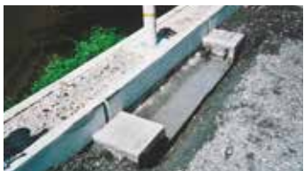
③底版上の土を取り除いた状況
