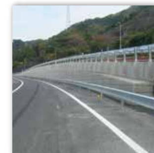
大型ブロック積擁壁
